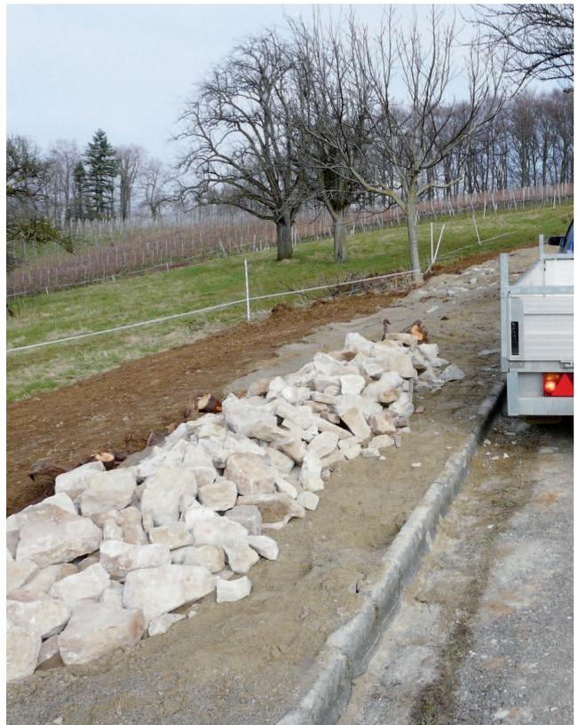
**Abb. 4 bis 7** (von oben links): Nachdem die oberste Bodenschicht entfernt worden war, wurden an mehreren Stellen ca. 1 m<sup>3</sup> tiefe Löcher gegraben und mit Wurzelstöcken aufgefüllt. Dann wurden auf der Fläche frost-sichere Steine verteilt und auf die Schotterschicht eine Schicht Sand aufgetragen. Den Abschluss des Steinriegels bildeten regionaltypische Blocksteine.
