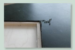
Hierbei sollte darauf geachtet werden, dass eine Tropfkante entsteht: Die Dachpappe sollte über die Holzleisten hinausragen.
